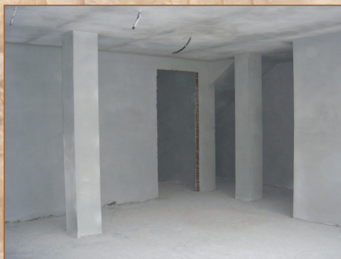
Lo stesso interrato dopo l'intonacatura sia di pareti che di soffitti.
