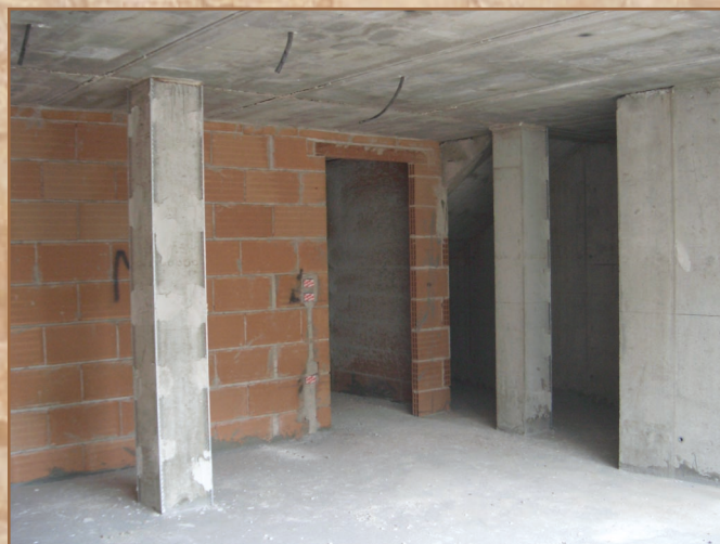
Interrato al grezzo di una abitazione.
