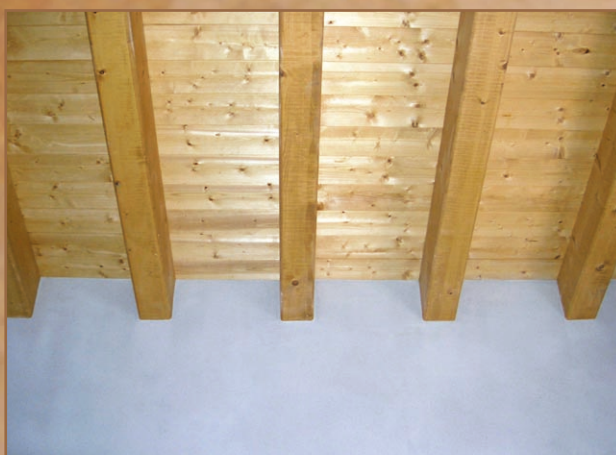
Particolare d'intonacatura su soffitto in legno.
